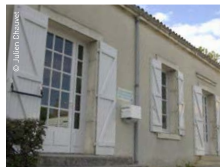
Accueil du SAD – avenue Carnot
